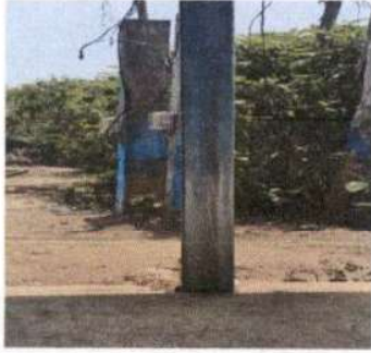
Foto 1: Sustrucción de estructura de soporte metal por metal.
