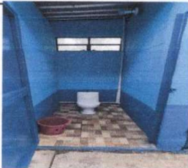
Foto 5: Sustrucción de 4 inodoros.
