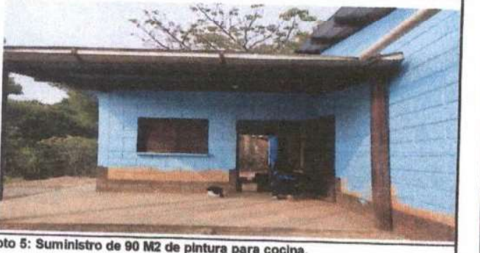
Foto 5: Suministro de 90 M2 de pintura para cocina.
