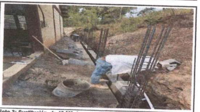
Foto 3: Sustitución de 19 M2 de muro perimetral
