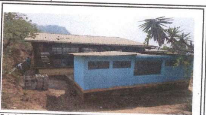
Foto 2: 90 M2 de pintura para baños y suministro de un tinaco.
