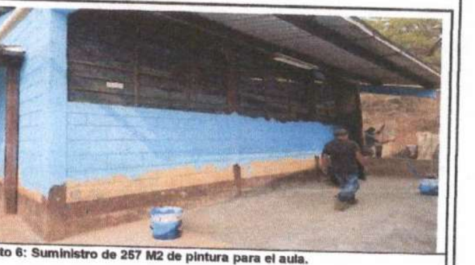
Foto 6: Suministro de 257 M2 de pintura para el aula.
