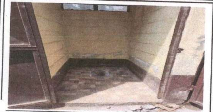
Foto 1: Sustitución de 4 inodoros.
