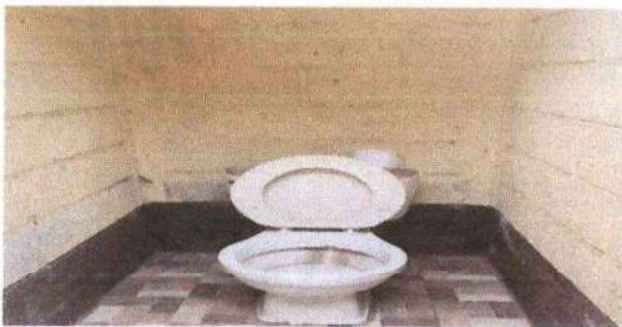
Foto 5: Sustrucción de 4 inodoros
