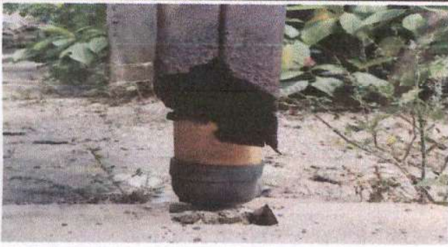
Foto 1: Sustrucción de estructura de soporte metal por metal.
