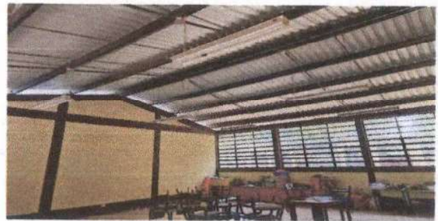
Foto 4: Sustrucción de lamparas.
