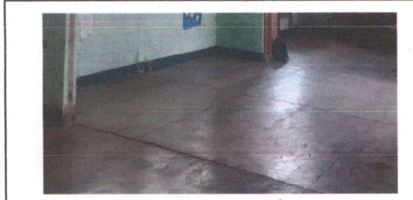
Foto 5: Instalacion de Piso
