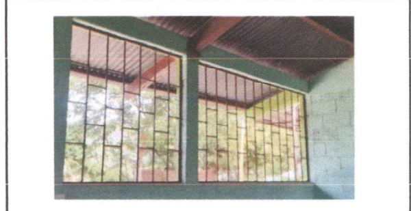
Foto 4: Instalacion de Ventanas
