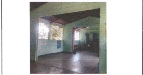
Foto 2: Instalacion de un Tabique.
