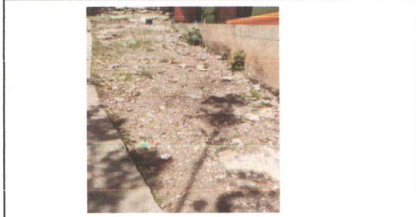
Foto 3: Sustitucion de losa
