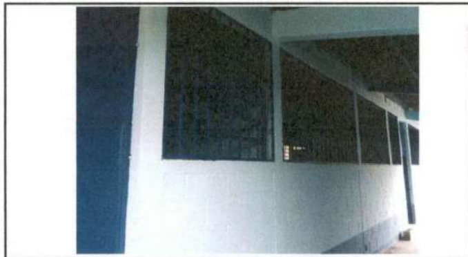
Foto 3: Mantenimiento a balcones y ventanas.
