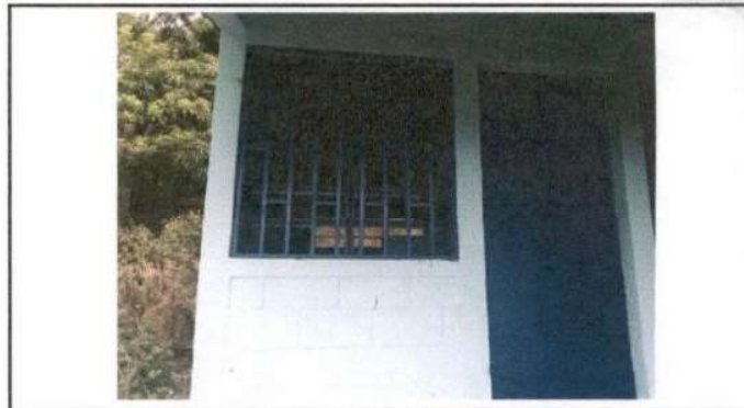
Foto 4: Elaboración y colocación de balcones en baños.
