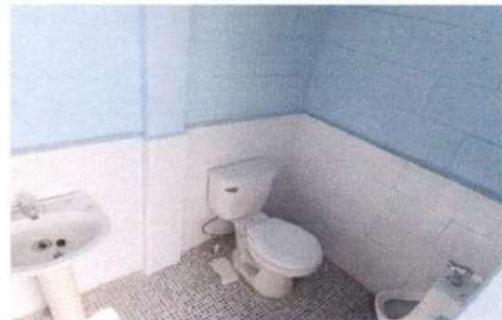
foto 6. sustitución de torta de cemento por cerámico
