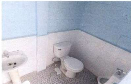
Foto 5, sustitución de mingitorio
