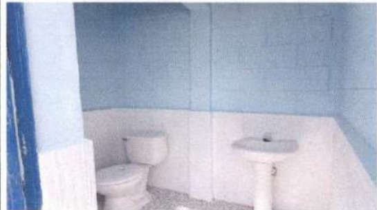
Foto 4. sustitución de lavamanos y inodoro
