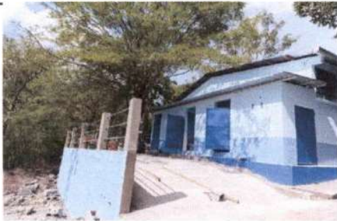
foto 3. reparacion de concreto de cemento de patio
