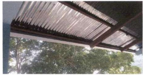
Foto2 sustitución de canales de metal
