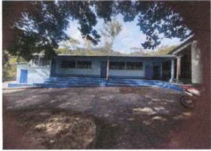
FOTO 7. Pintrura de muro interior y exterior
