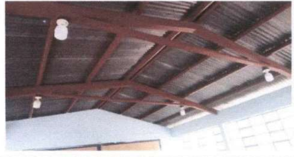
Foto 8, Sustitución de lámparas
