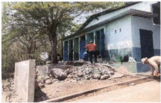
foto 1: sustitución de lámina por lámina troquelada
