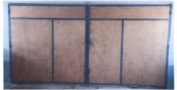
Foto 10. reparación de poton
