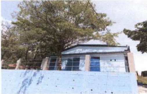
foto 9. reparación de muro
