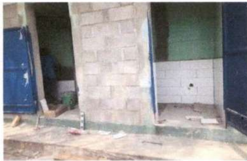
Foto 3: sustitución de torta de cemento por cerámico
