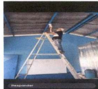
Foto 6: sustitución de lámparas
