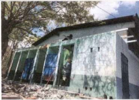
foto 1: sustitución de lámina por láminia troquelada
