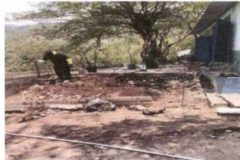
Foto 4: reparación de concreto de cemento de patio
