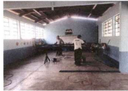
Foto 2: mantenimiento de porton
