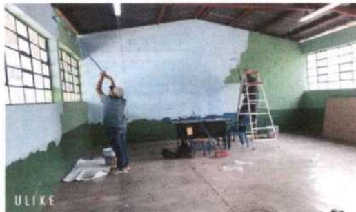
foto 5 : pintura de muro Inerior y exterior
