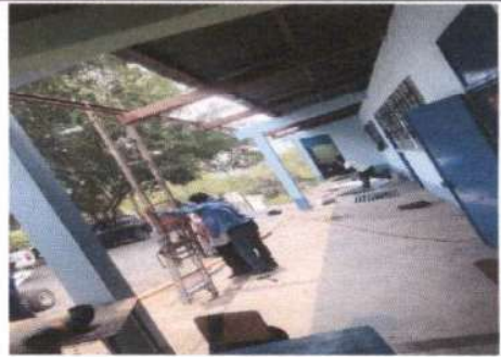
Foto 8: sustitución de canales de metal
