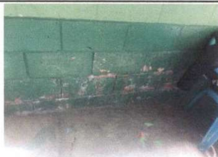
foto 5 : pintura de muro inerior y exterior
