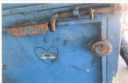
foto 2: sustitución de chapas
