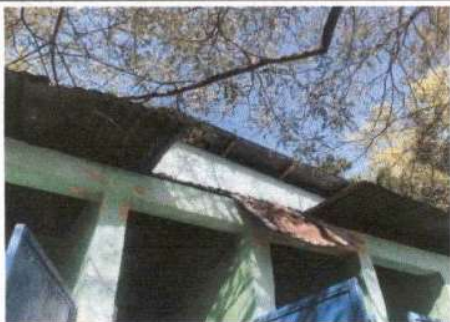
foto 1: sustitución de lámina por láminia troquelada
