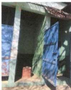
Foto 3: sustitución de torta de cemento por cerámico
