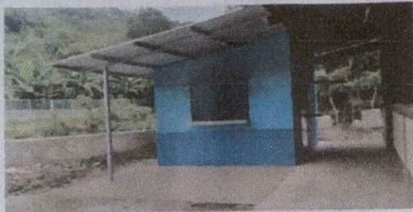
Foto1: Sustitución completa de paredes de cocina
