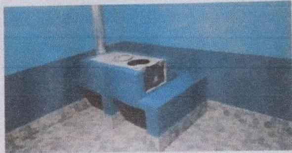
Foto 4: Sustitución de hornilla por estufa
