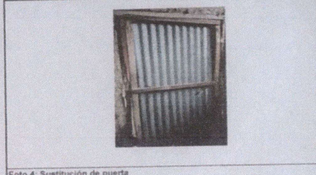
Foto 4: Sustrucción de puerta
