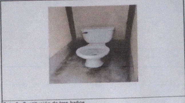
Foto 2: Sustrucción de tres baños
