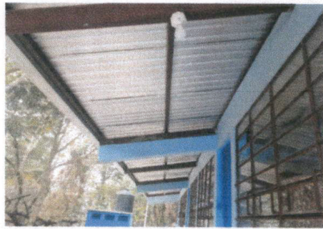
Foto 9: Reparación de Canales.
