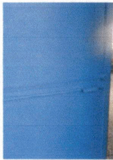
Foto 3: Cambio de Pintura de Puerta.
