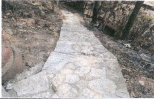
Foto 7: Reparación Rampa de Acceso.
