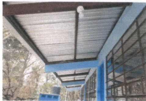
Foto 10: Reparación de Techo.
