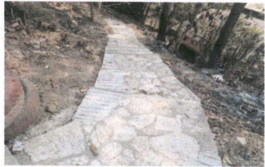
Foto 8: Reparación Rampa de Acceso.
