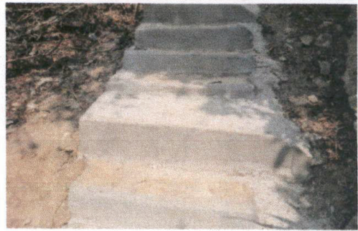
Foto 4: Reparación gradas de acceso.
