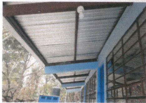
Foto 11: Reparación de cables de energía eléctrica.
