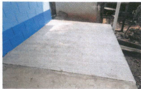
Foto 6: Reparación de Acera.
