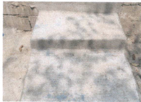
Foto 12: Reparación rampa de acceso.
