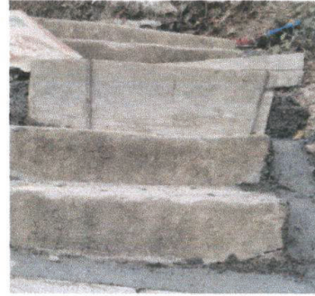
Foto 8: Reparación Rampa de Acceso.
