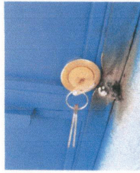
Foto 2: Reparación de Chapa de Puerta.
