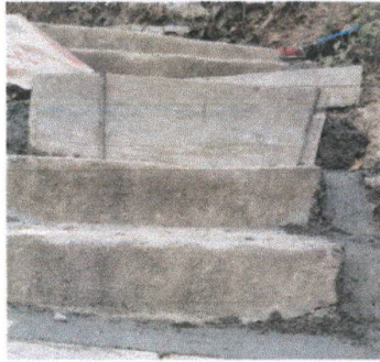
Foto 7: Reparación Rampa de Acceso.
