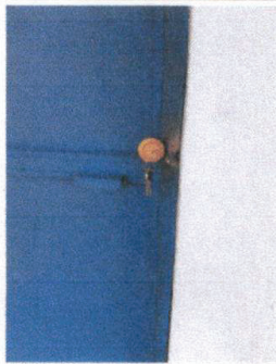
Foto 3: Cambio de Pintura de Puerta.
