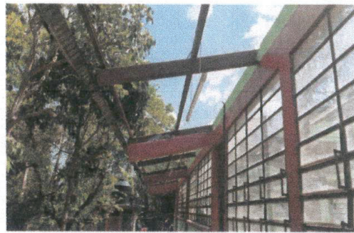
Foto 10: Reparación de Techo.
