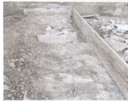
Foto 12: Reparación rampa de acceso.
