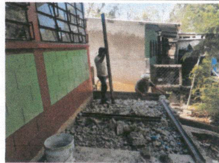
Foto 6: Reparación de Acera.
