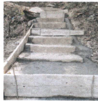
Foto 4: Reparación gradas de acceso.
