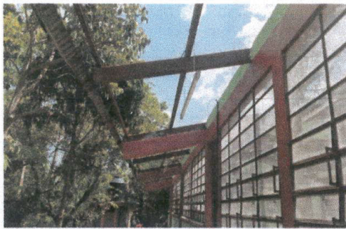
Foto 9: Reparación de Canales.
