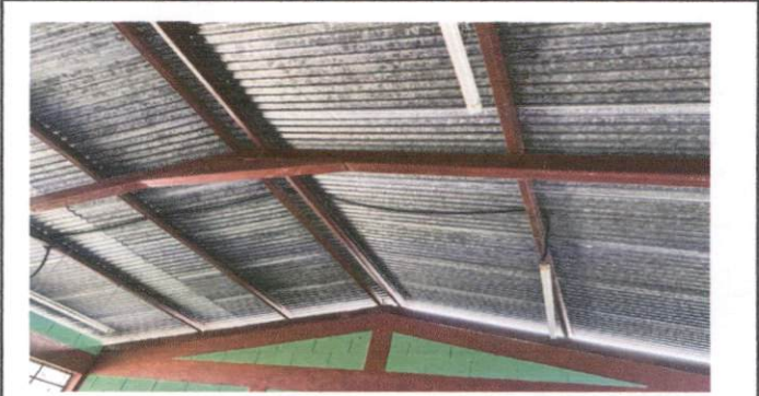
Foto 4: Cambio de techo
