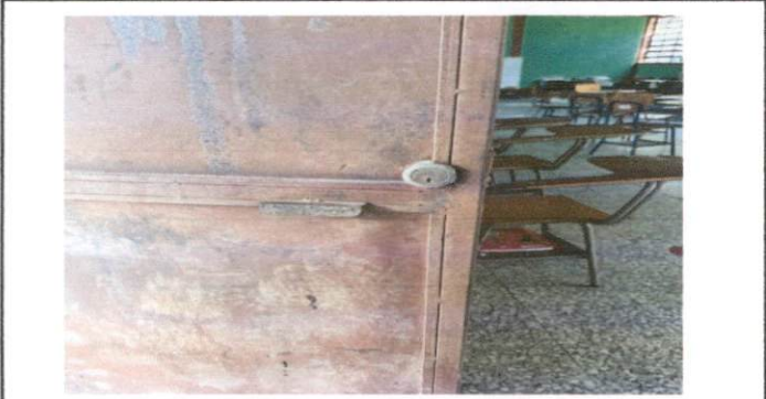
Foto 3: Cambio de chapas de puertas
