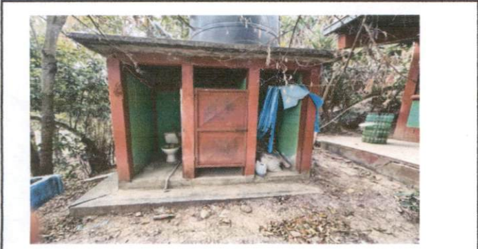
Foto 1: Remodelación de baños
