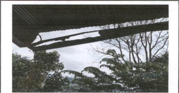
Foto 2: Cambio de canales
