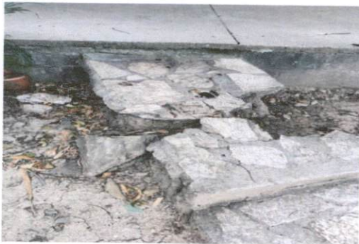
Foto:9 Rampa de Acceso
