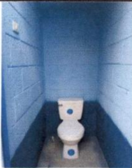
Foto 3: Colocación y Pintura de Servicios Sanitarios
