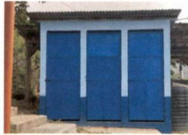
Foto 4: Sustitución de Puerta de Salón
