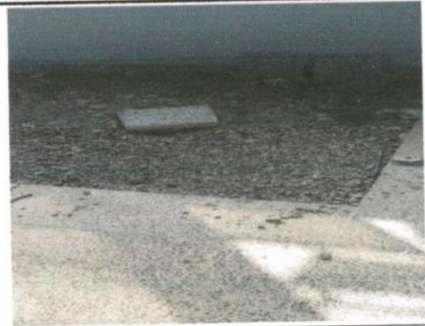
Foto 6. Reemplazo de piso en área dañada.
