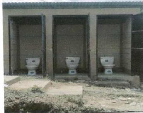
Foto 4. Reemplazo de servicios sanitarios, reparación de puertas y pintura.
