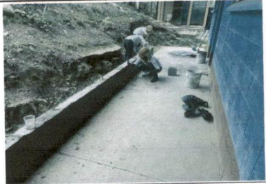
Foto 2. construcción de muro.
