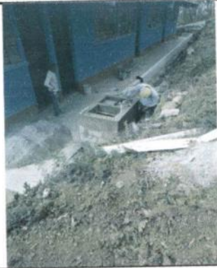
Foto 1. Construcción de muro y pila.
