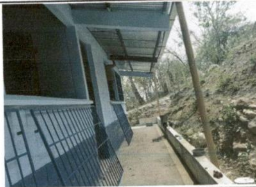
Foto 3. Colocación de balcones.
