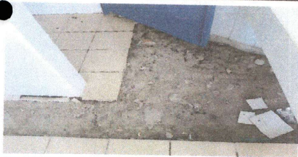
Foto 5: El piso ceramico del sanitario de hombres deteriorado
