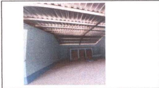
Foto 2: Fraguado de Patio de los Baños.
