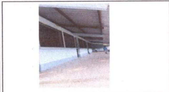
Foto 3: Ampliación de techo de corredor.
