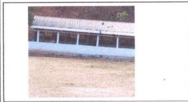
Foto 5: Sustitución de Pintura del INEB.
