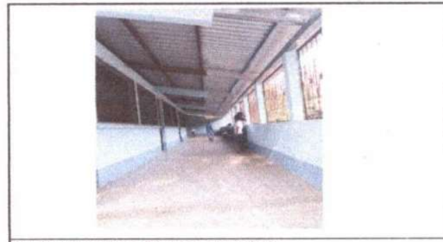
Foto 6: Ampliación de Piso bajo área techada.
