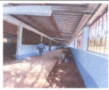
Foto 6: Ampliación de Piso bajo área techada.
