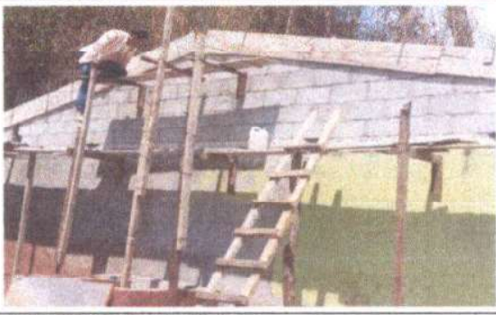
Foto 1: Ampliación de muro y techo.
