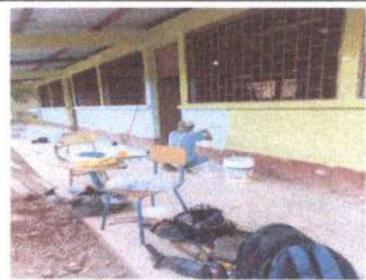
Foto 5: Sustitución de Pintura del INEB.
