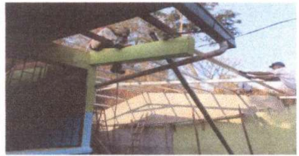
Foto 3: Ampliación de techo de corredor.
