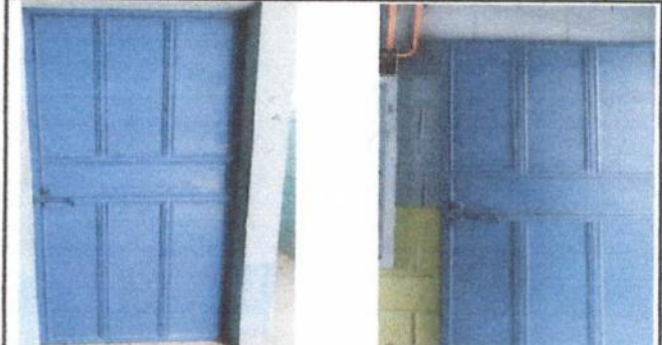
Foto 2: mantenimiento a estructuras de puerta (lijado, cambio de tubo, cepillado, sujeciones, aplicación de pintura)
