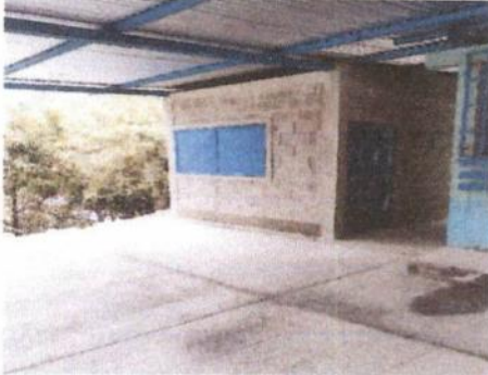
Foto 1: sustitución de estructura de soporte (madera) por metal. (estructura y cubierta metálica)
