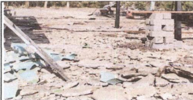
Foto 5: reparación de piso de torta de concreto (Incluye un tramo de banqueta)
