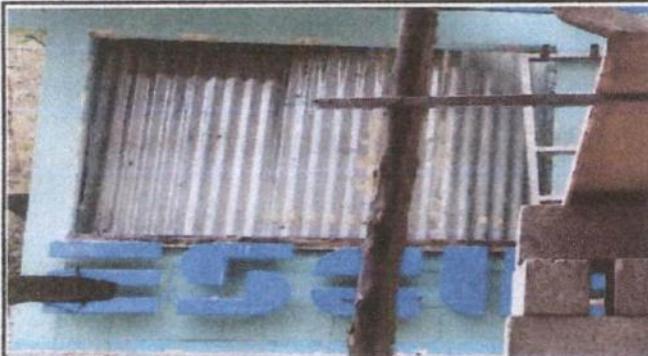
Foto 3: mantenimiento a ventana (nuevas) (estas ventanas se realizará un boquete en muros existentes y se instalará ventana de concreto prefabricadas)
