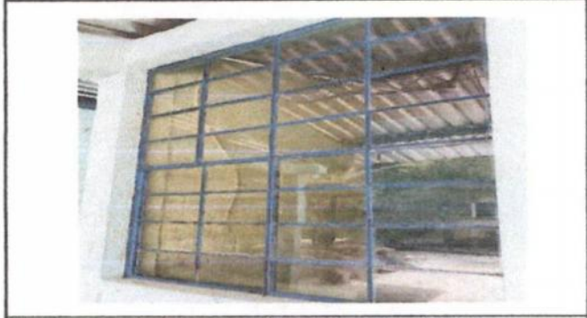
Foto 4: sustitución de estructura de metal de ventana (nueva)
