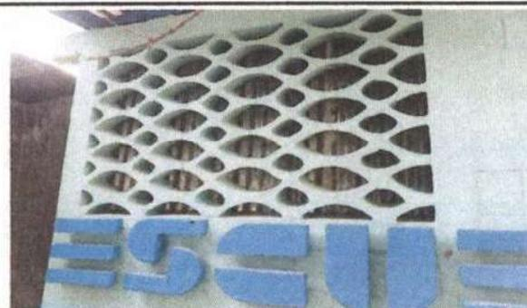
Foto 3: Mantenimiento a ventana (nuevas) (Estas ventanas se realizará un boquete en muros existentes y se instalará ventanas de concreto prefabricadas.)
