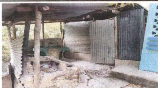
Foto 1: Sustrucción de estructura de soporte (madera) por metal. (Estructura y cubierta metálica)
