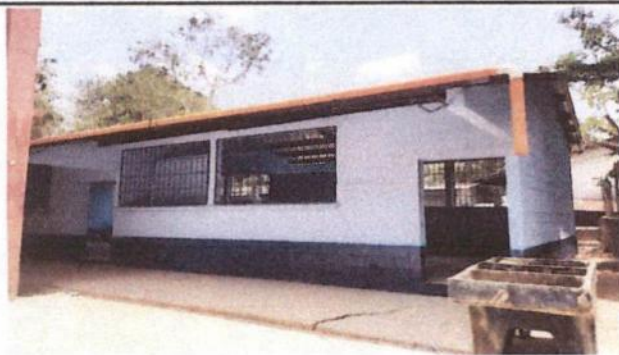
Foto 3: Instalación de balcones nuevos finalizado.
