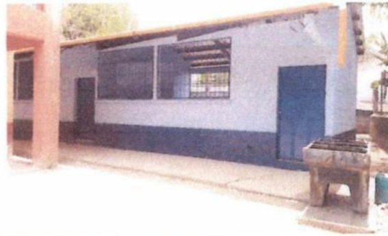
Foto 2: Puertas ya instaladas
