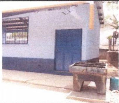
Foto 5: Plancha para colocar pila finalizada.
