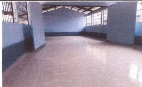
Foto 4: Colocación de piso cerámico en aulas finalizado.
