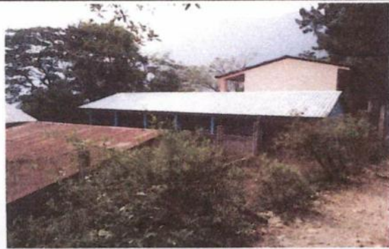
Foto 1: Techo finalizado, con lámina nueva y su estructura metálica reparada.
