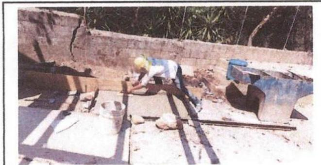
Foto 5: Elaboración de plancha para colocar la pila.
