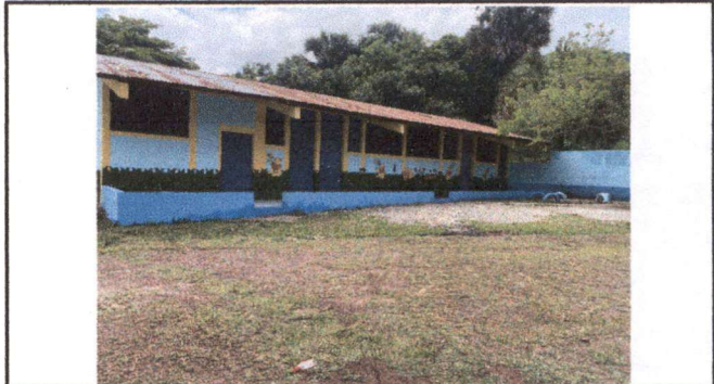
Foto 4: Pintura de paredes de interiores y exteriores.
