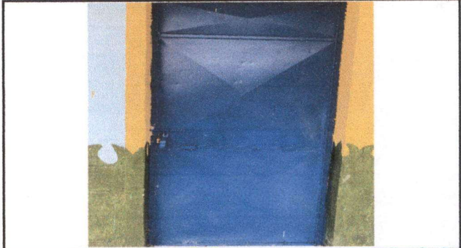
Foto 2: Mantenimiento de pintura a puertas.
