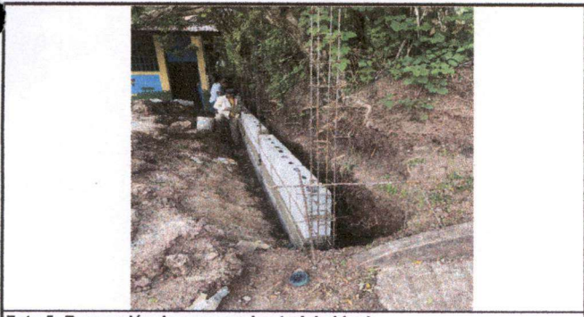
Foto 5: Reparación de muro perimetral de block.
