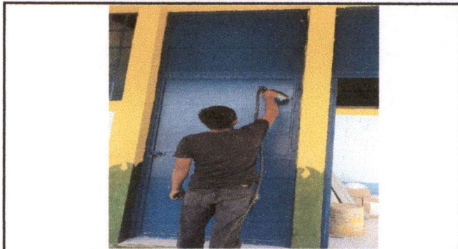
Foto 2: Mantenimiento de pintura a puertas.
