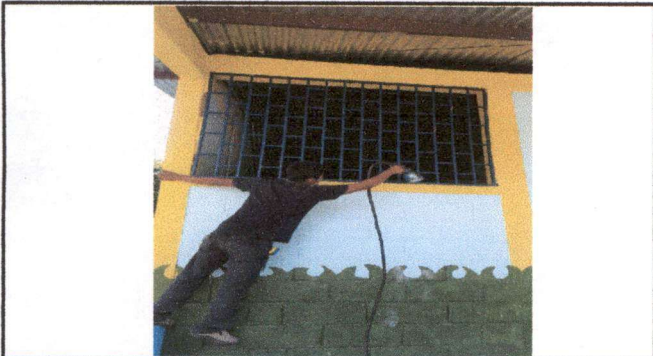
Foto 3: Mantenimiento de pinturas a balcones.
