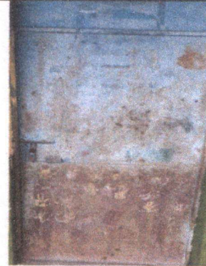
Foto 2: Mantenimiento de pintura a puertas.
