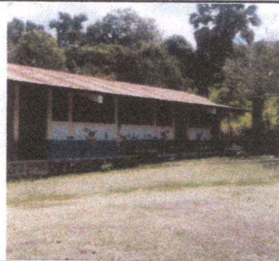
Foto 4: Pintura de paredes de interiores y exteriores.
