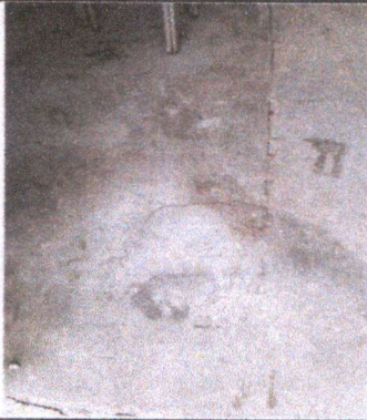
Foto 1: Sustrucción de piso de concreto por piso cerámico.
