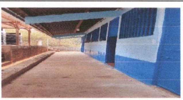
Foto:4 Instalación de canales metálicos
