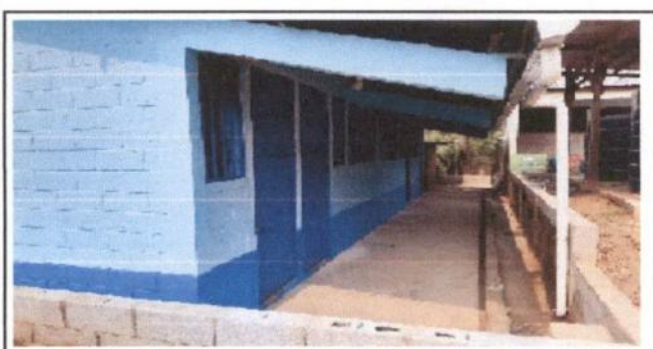
Foto:5 Levantado de muro de block
