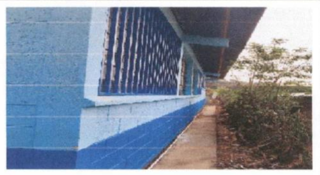
Foto: Cambio de Vidrios quebrados
