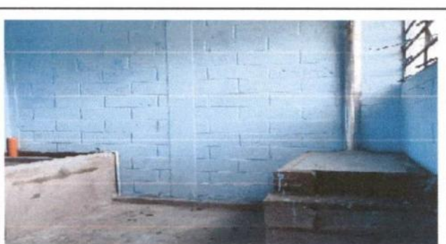
Foto:6 Instalación de Estufa Ahorradora
