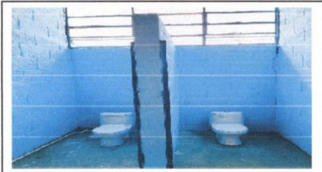
Foto: 3 Sustitución de baños
