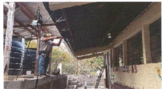
Foto:4 Instalación de canales metálicos
