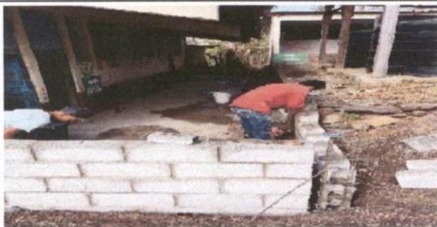
Foto:5 Levantado de muro de block
