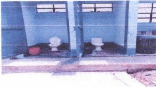
Foto 1: cambio de sanitarios ,pintura y pavimento en la entrada.
