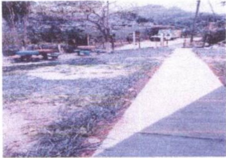
Foto 3: Pavimento de la entrada de la escuela
