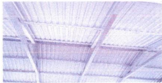
Foto 6: Colocación de Estructura Metalica y Techo
