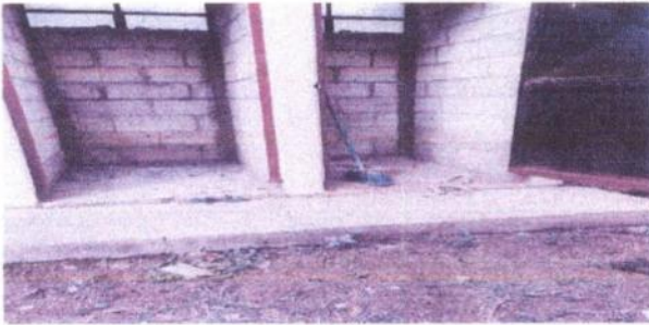
Foto 5: Desmontaje de baños
