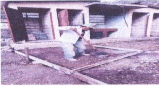
Foto 1: Pavimento de la escuela hacia los baños
