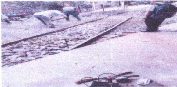
Foto 3: Pavimentación de la entrada al Centro Educativo
