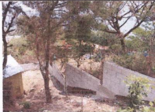
Foto 2: Remozamiento de muro perimetral renglón 15
