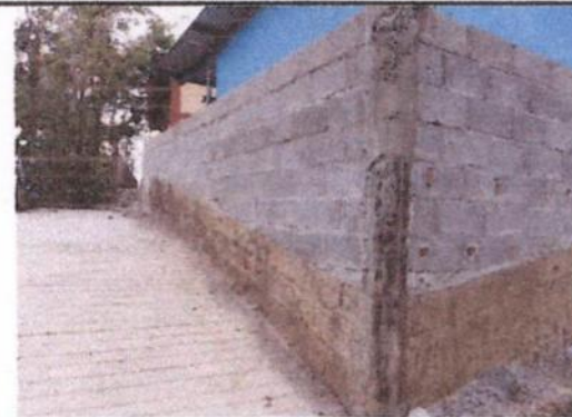
Foto 4: Remozamiento de muro perimetral renglón 15
