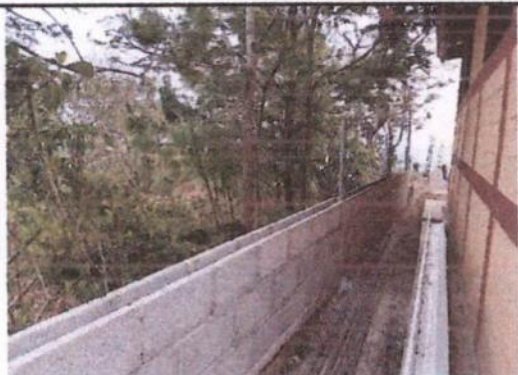
Foto 3: Remozamiento de muro perimetral Renglón 15
