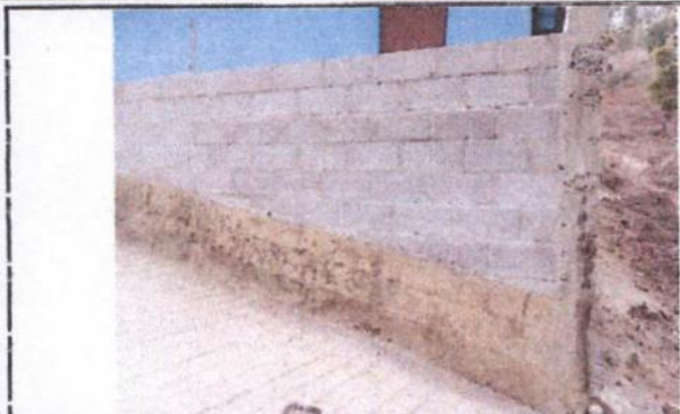
Foto 1: Remozamiento de muro perimetral renglón 15
