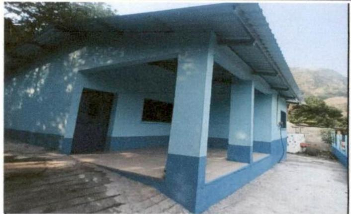
Foto 2: Sustitución de Techo de Madera a Metal
