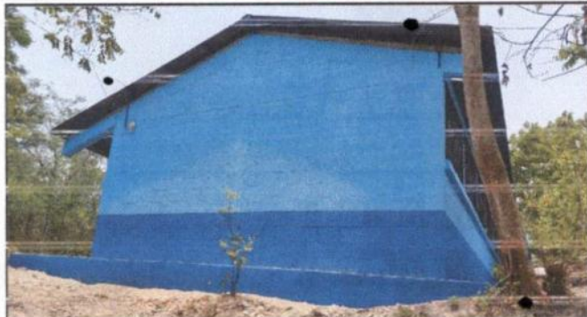
Foto 1: Reparación de Banqueta en mal estado.
