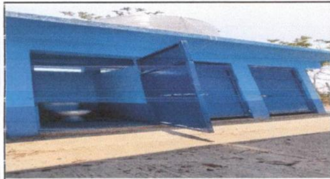
Foto 3: Reparación de Baños.
