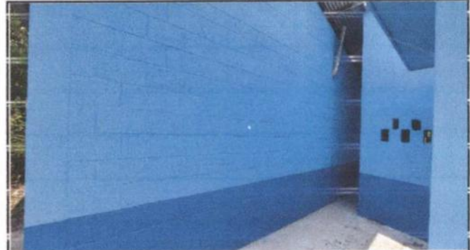
Foto 2: Pintura de Paredes
