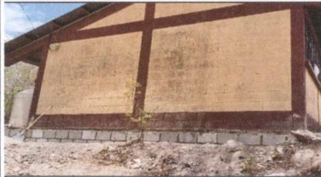
Foto 1: Reparación de Banqueta en mal estado.
