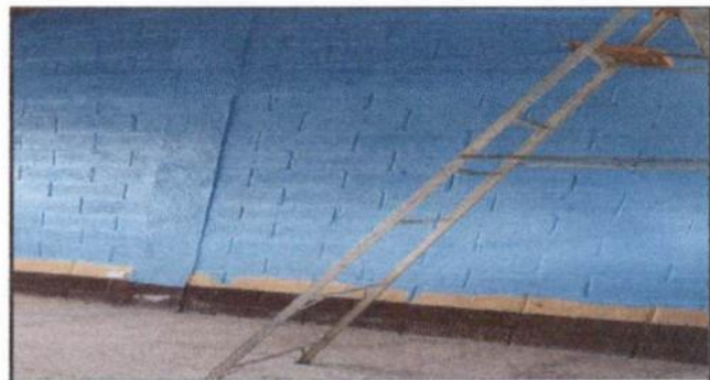
Foto 6: Cubierta de pintura para proteger paredes de humedad.
