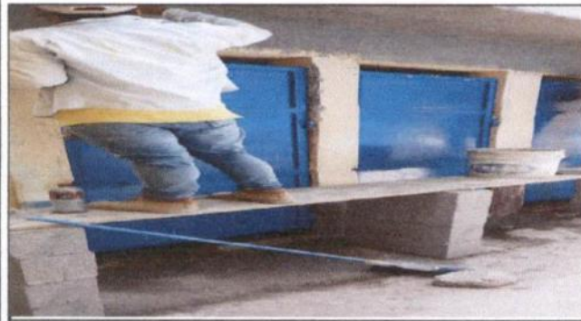
Foto 3: Reparación de Baños.
