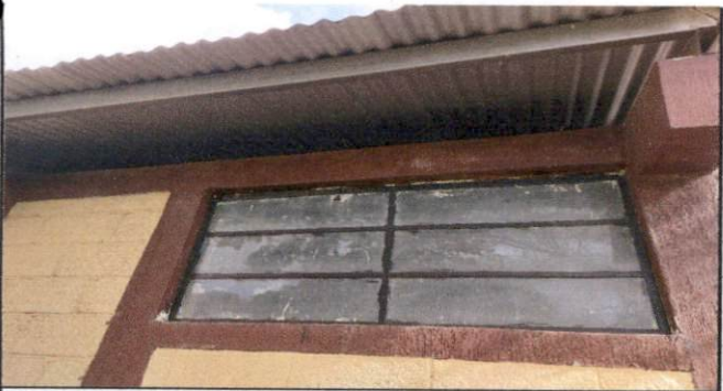
Foto 5. Espacio entre lámina y pared. Se suben a robar.
