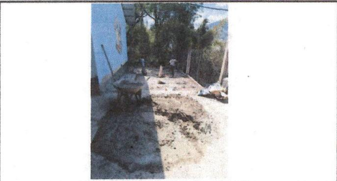
Foto 3: Sustitución de piso de torta de cemento, 20 metros.
