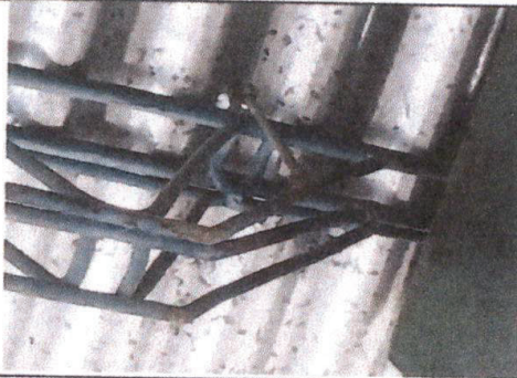
Cambio de estructura
