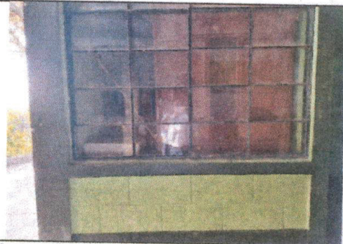
Reparación de ventana
