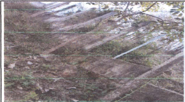
MURO PERIMETRAL, PARTE DE ABAJO
