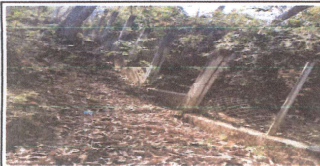
MURO PERIMETRAL, PARTE ENTERRADA, PROBOCADA POR LAS LLUVIAS
