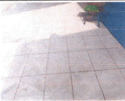
Colocación de piso ceramico
