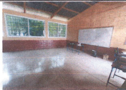
Colocación de piso ceramico en aulas.
