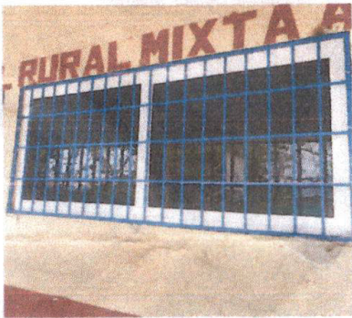
Aplicación de pintura de balcones
