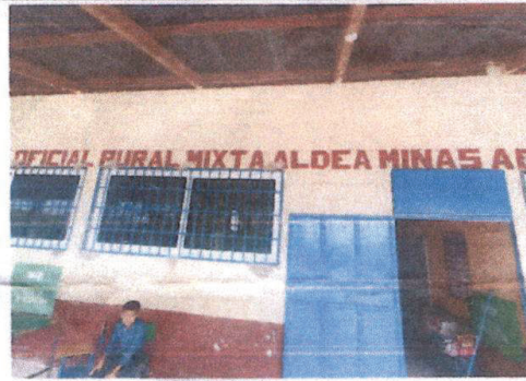
Cambio de barillas de acero a balcones
