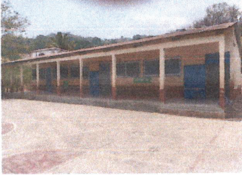
Colocación de Ventanas y balcones
