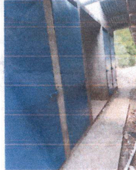
Colocación de puertas de servicios sanitarios
