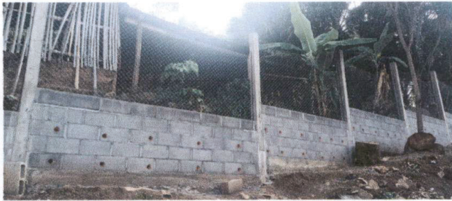
REPARACION DE MURO PERIMETRAL
