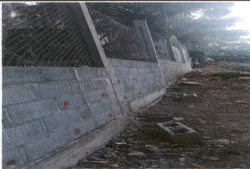
REPARACION DE MURO PERIMETRAL
