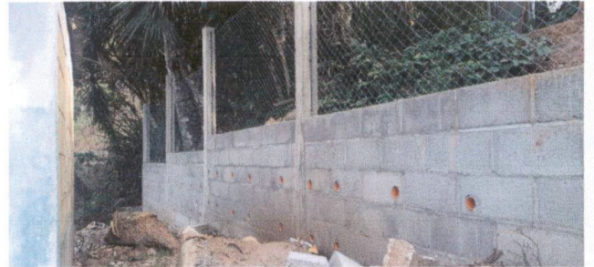
REPARACION DE MURO PERIMETRAL
