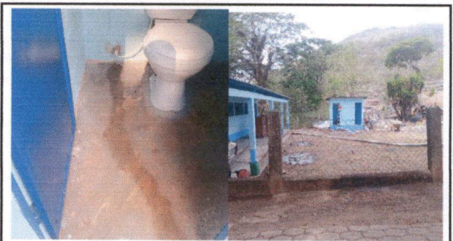
proceso de reparación de servicios sanitarios
