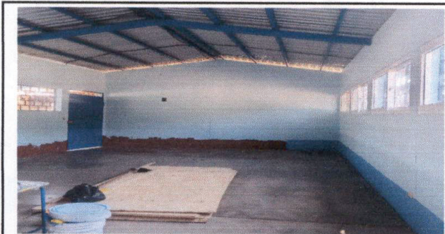
proceso de pintado en las aulas
