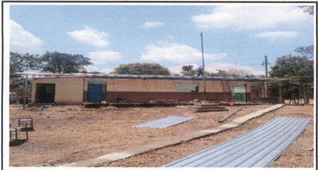
Proceso de reparación del techado de aulas antiguas
