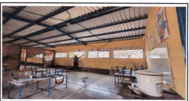
proceso de instalacion de ventanas PVC
