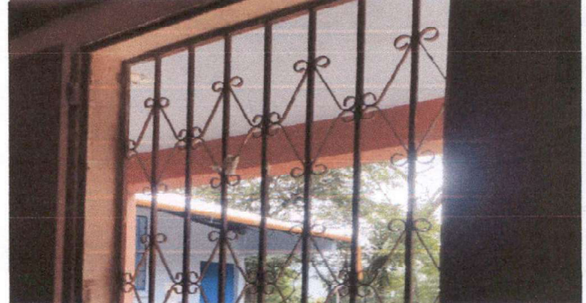
aplicación de pintura en balcones
