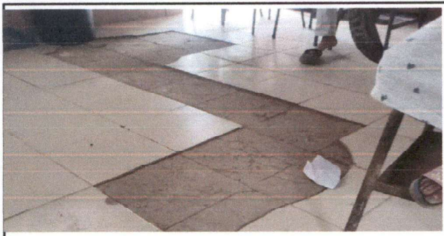
Sustitucion de piso
