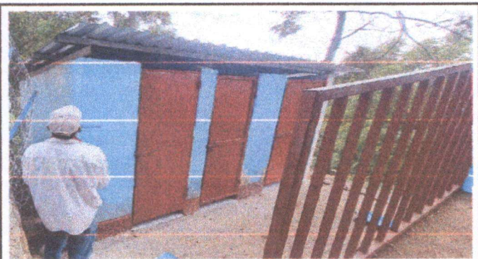
Foto 3: Sustitución y mantenimiento de inodoros.
