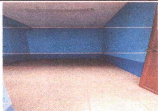
Foto 5: Sustitución de 125 M2 de piso de concreto, por piso ceramico.
