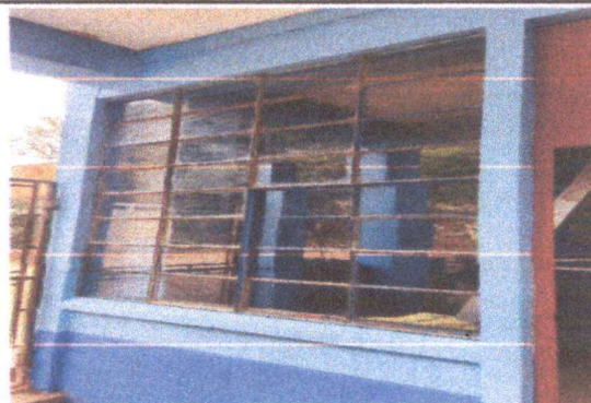
Foto 2: Sustitución de 42 vidrios.
