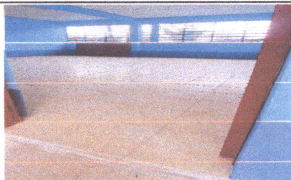
Foto 4: Sustitución 125 M2 de piso de concreto, por piso ceramico.
