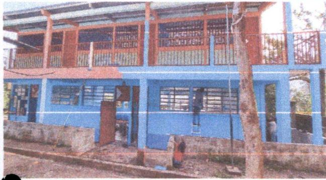
Foto 1: Pintura de muros exteriores e interiores.
