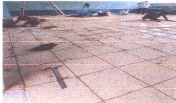
Foto 2: Sustitución de piso de concreto por piso de cerámico.
