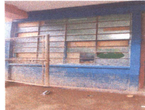
Foto 2: Sustitución de Vidrios.
