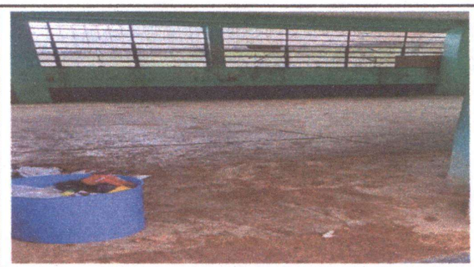
Foto 2: Sustitución por piso de ceramico primer nivel.
