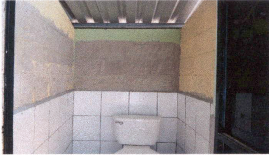
Foto 1: Los baños fueron totalmente cambiados por tazas nuevas, lavables, solo falta la pintura.
