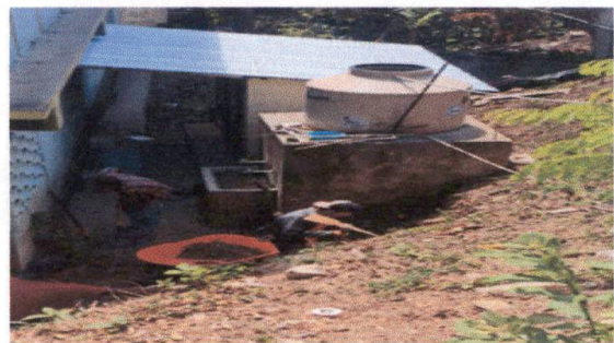
Foto 4: La tubería de agua para uso diario de nuestros niños esta siendo mejorada.
