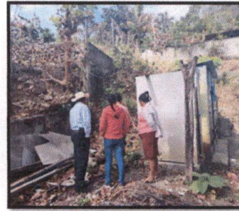
Foto No. 2: La tubería o drenajes de los onodoros está en mal estado.
