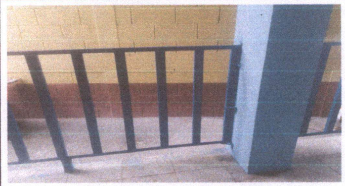
FOTO 2: Mantenimiento a barandas de metal en pasillos
