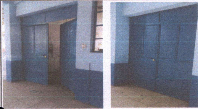
FOTO 1: Mantenimiento a estructura de puertas (lijado, cambio de tubo, cepillado, sujeciones, aplicación de pintura)
