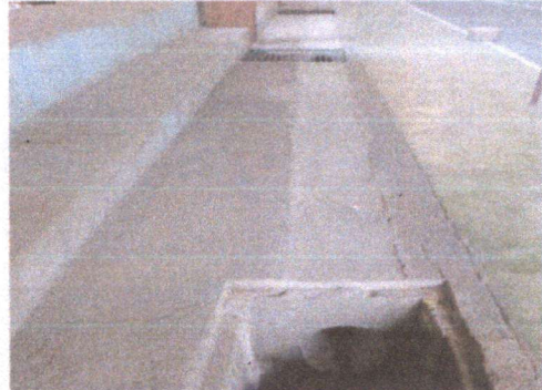
FOTO 6: Reparación de tubería de drenaje pluvial
