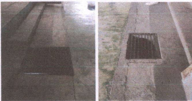
FOTO 5: Reparaciones en cajas de drenaje pluvial
