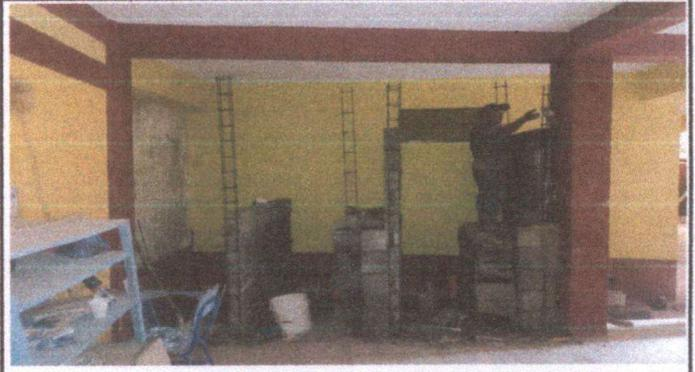
FOTO 8: Levantado de muro para area de baño
