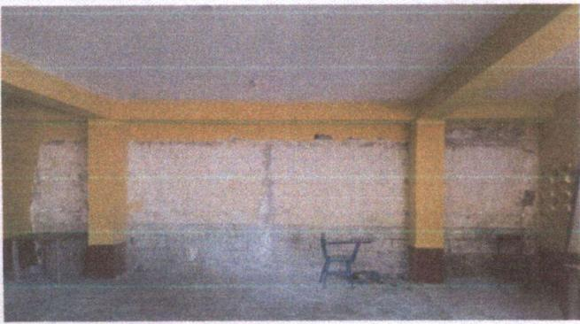
FOTO 7. Remozamiento de repello en muro
