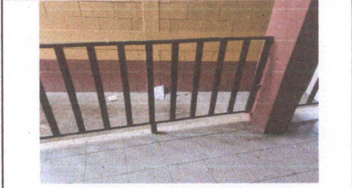
FOTO 2: Mantenimiento a barandas de metal en pasillos
