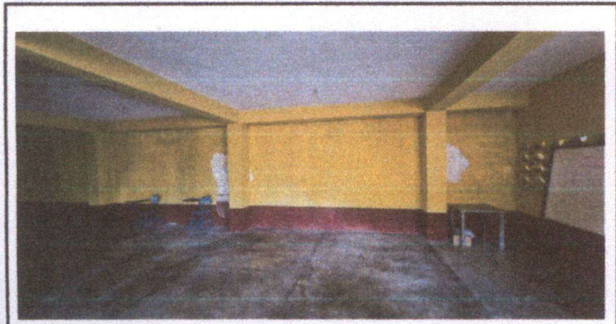
FOTO 7. Remozamiento de repello en muro
