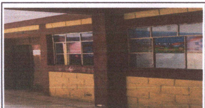
FOTO 9: Aplicación de pintura en muros
