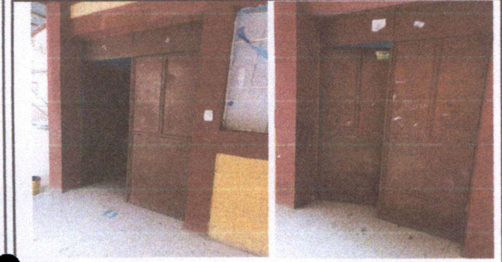
FOTO 1: Mantenimiento a estructura de puertas (lijado, cambio de tubo , cepillado, sujeciones, aplicación de pintura)
